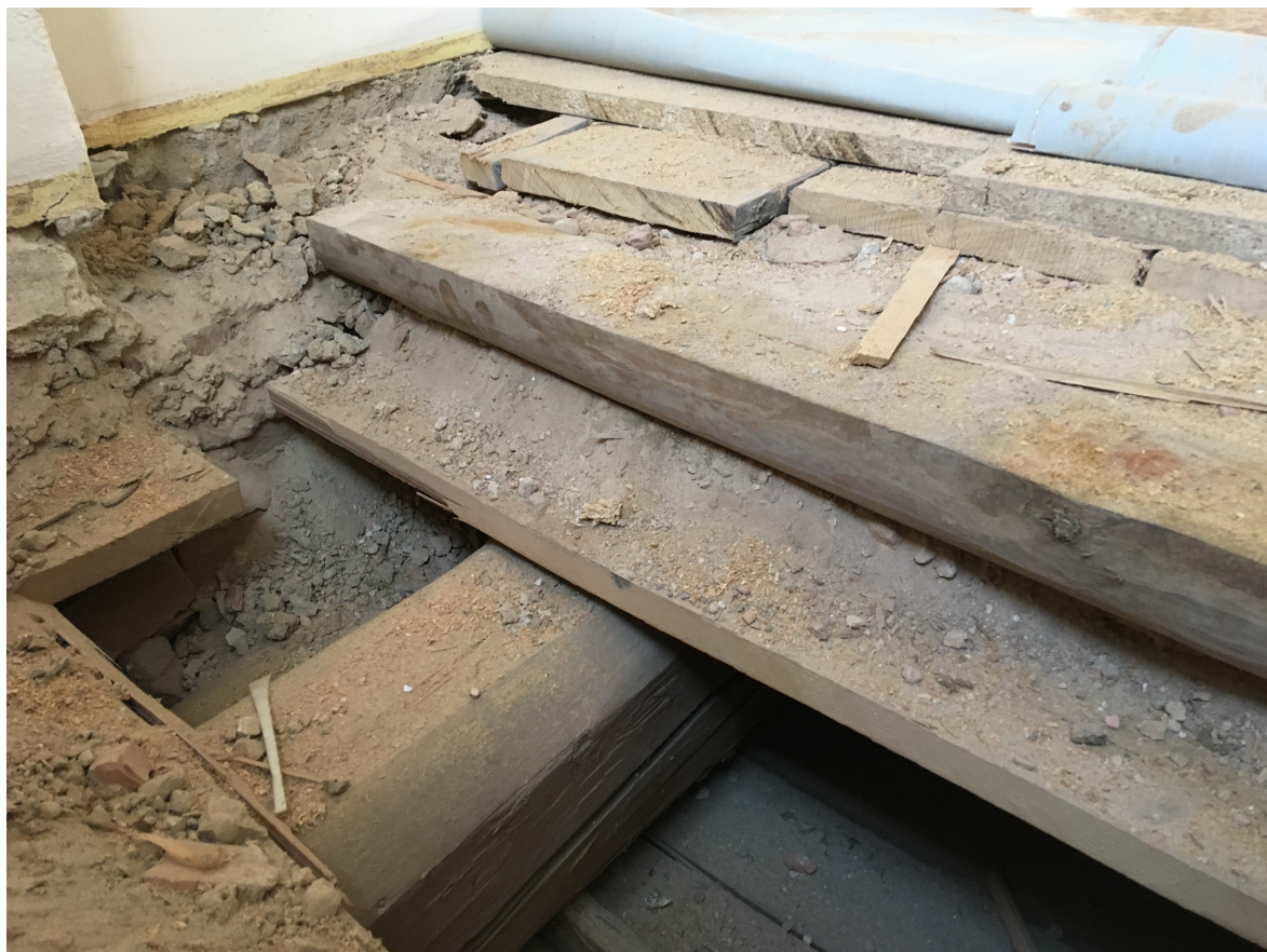
Obr. 1 – skladba stávající podlahy
